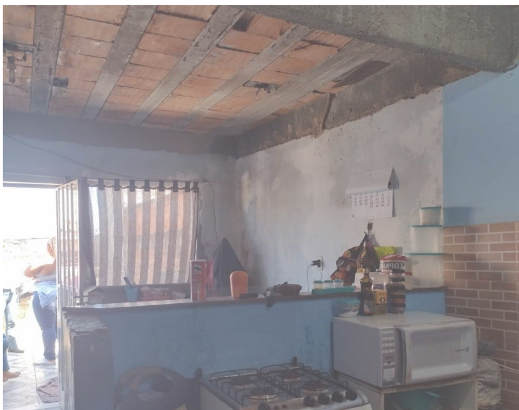
Laje sem forro, Fonte: Autores, 2022
