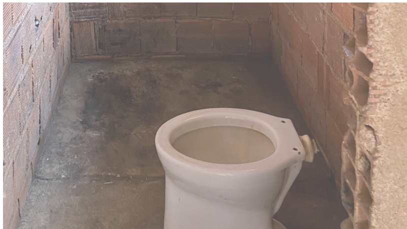
Piso em cimento grosso, Fonte: Autores, 2022
