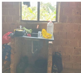
Residência em Japeri, Fonte: Autores, 2022
