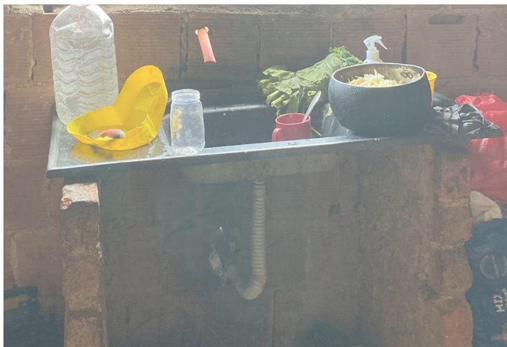
Pia sem abastecimento de água, Fonte: Autores, 2022
