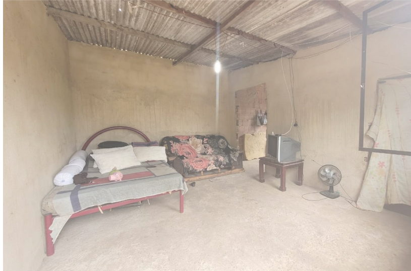
Piso em cimento grosso, Fonte: Autores, 2022
